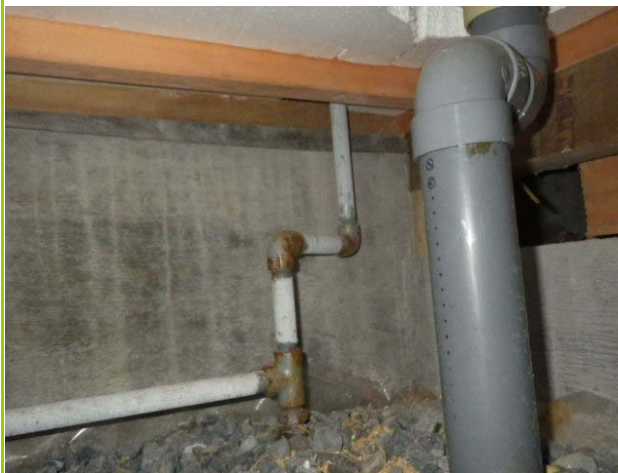
写真1. 床下状況 基礎際部
